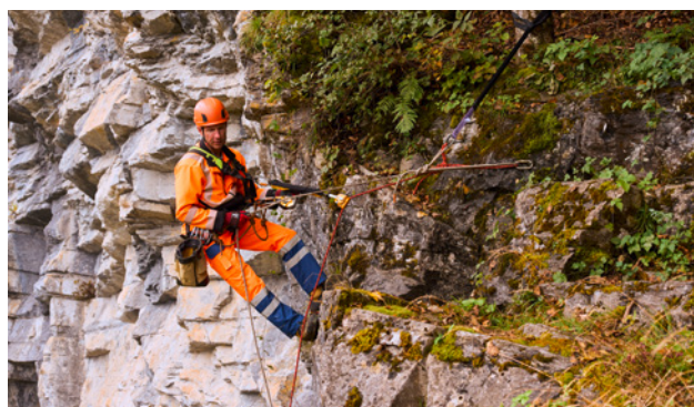
2 Systemredundanz durch unabhängige Verankerung von Arbeits- und Sicherungssystem
