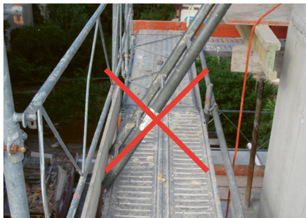
4 Pericolo! Questa scala a pioli poggia su una superficie instabile. In caso di cedimento della tavola fermapiedi, la caduta sarebbe inevitabile.
