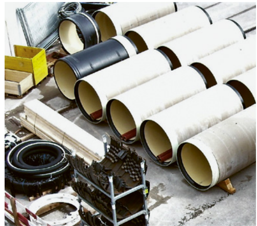
2 Système de stockage réglementaire des tuyaux d'avancement.
