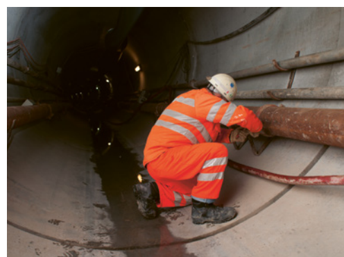
5 Les travaux d'avancement comprennent toujours des situations particulièrement contraignantes au niveau physique et nécessitant une extrême prudence, p. ex. lors des travaux d'entretien dans la zone d'avancement ou sur les équipements de travail.
