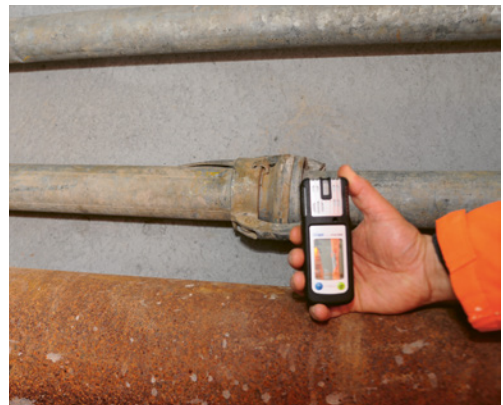
3 La surveillance de la qualité de l'air dans la zone d'avancement joue un rôle essentiel pour la sécurité des travailleurs.
