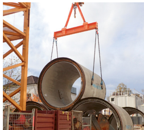
4 L'utilisation d'engins et de dispositifs adéquats pour le transport des matériaux (ici: transport vertical) est primordiale.
