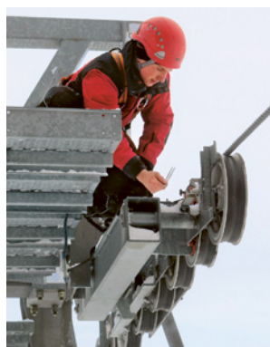
2 Enlever la barrette cassante sur les pylônes.
