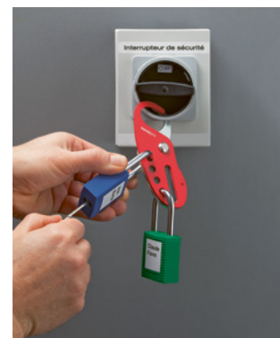
Règle 4 Arrêter et sécuriser l'installation.
