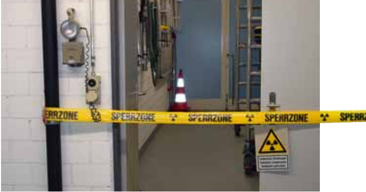
Absperrung vor dem Prüfbereich
