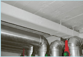
Canalina per cavi in fibrocemento
