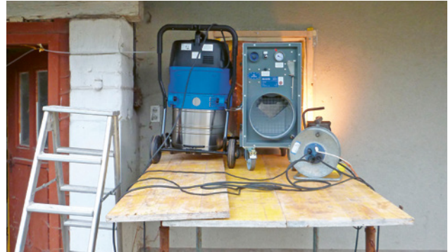
3 Apparecchio estrattore integrato in una finestra e sigillato ermeticamente. Il tubo flessibile dell'aspirapolvere passa attraverso la parte sigillata.
