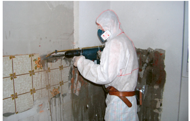
1 Occorre rimuovere le piastrelle con colla contenente amianto usando un martello demolitore dotato di nebulizzatore.
