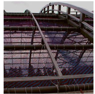
6 Weltweit einer der ersten Einsätze beim Bau der Masoala-Halle in Zürich
