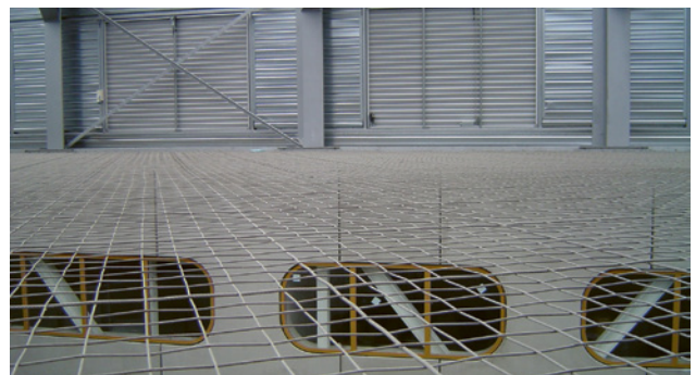
7 Variante: rostfreie Drahtseile für den Dauereinsatz → kein Auffangnetz!
