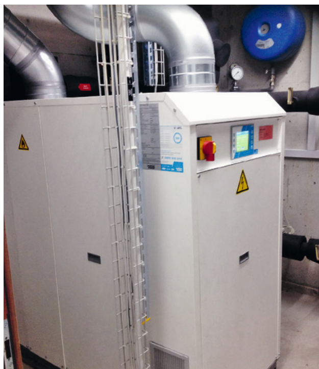
Sistema di refrigerazione in involucro ventilato
