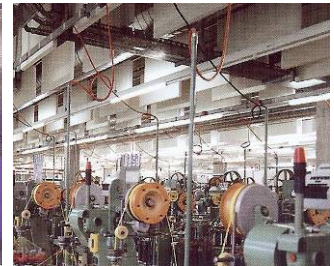
Akustikdecke absorbiert den Schall
