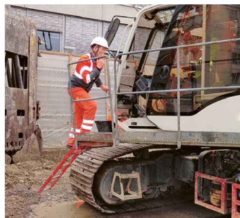
5 Monter et descendre correctement des engins de chantier pour éviter des accidents.
