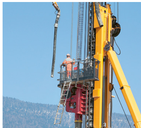
1 Nacelle permettant d'effectuer les travaux de maintenance nécessaires.
