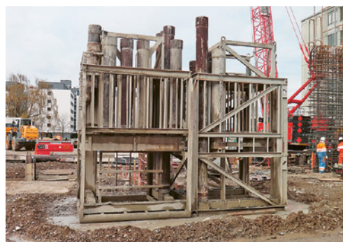
2 Système de stockage exemplaire des tubes plongeurs.
