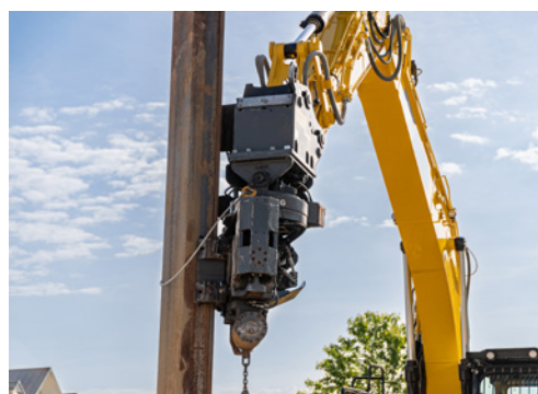
4 Les vibrofonneurs à prise latérale sont capables de mettre les pieux en position verticale, de les maintenir fermement et de les enfoncer dans le sol par vibration en une seule opération.
