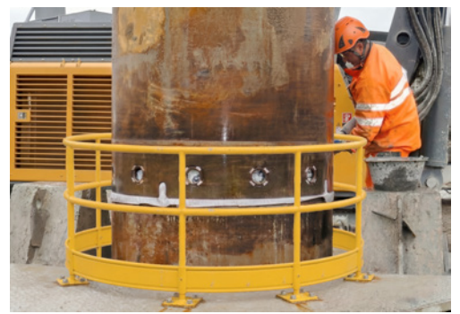
5 Lors de l'assemblage d'accessoires, le collaborateur risque de tomber, p. ex. s'il n'y a pas de garde-corps périphérique.
