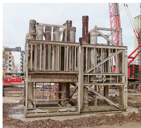
2 Système de stockage exemplaire des tubes plongeurs.
