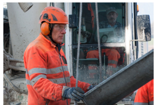
8 Les EPI standards sont un casque, des lunettes de sécurité et des gants de protection, des protecteurs d'ouïe (p. ex. tampons auriculaires), des bottes de sécurité et des vêtements de signalisation.
