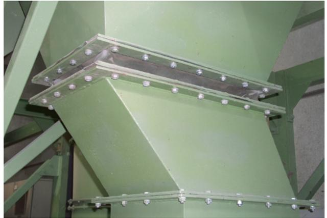
**69** Elemento di compensazione in plastica posizionato nella condotta di scarico dell'aria di un impianto di processo
