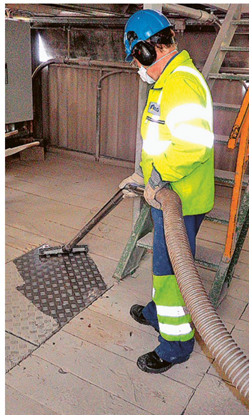
3 Rimozione di accumuli di polvere mediante un aspirapolvere
