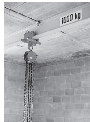
4 Inscription bien lisible de la charge maximale de la voie de roulement
