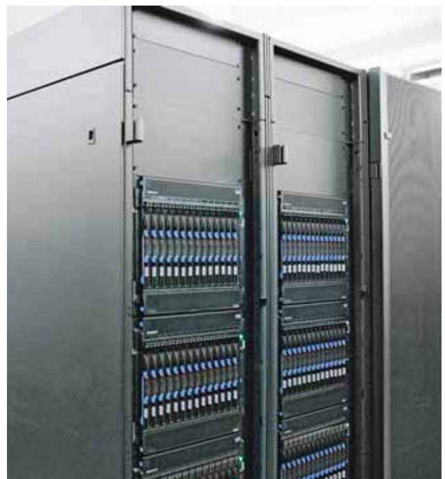
2 In Serverräumen werden Brände vermehrt durch eine sauerstoffreduzierte Atmosphäre vermieden.
