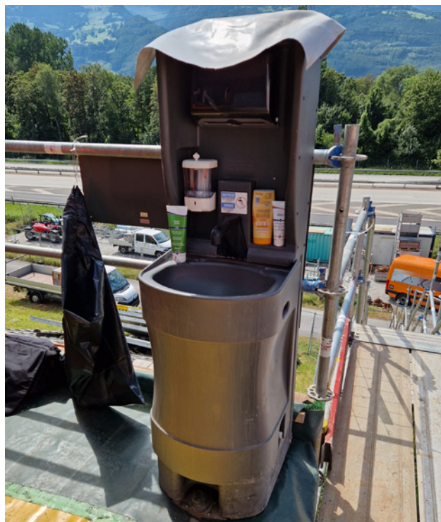
4 Postazione per il lavaggio di mani, braccia e viso al di fuori della zona di risanamento
