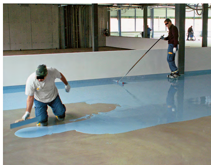
Fig. 2 Travail avec une résine époxy dans le bâtiment
