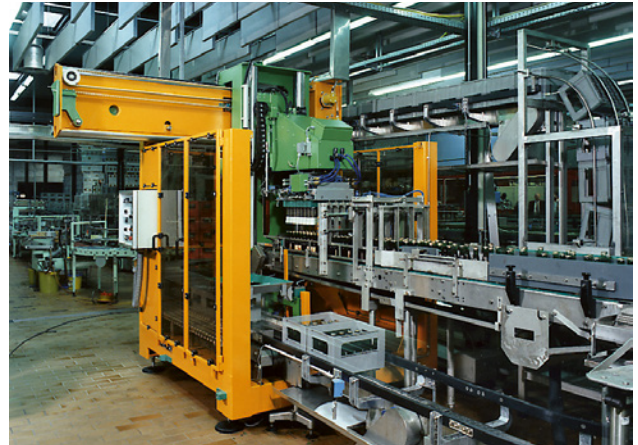
81 Plafond acoustique dans une halle de remplissage de bouteilles. Les panneaux acoustiques utilisés («baffles») sont en fibres minérales.
