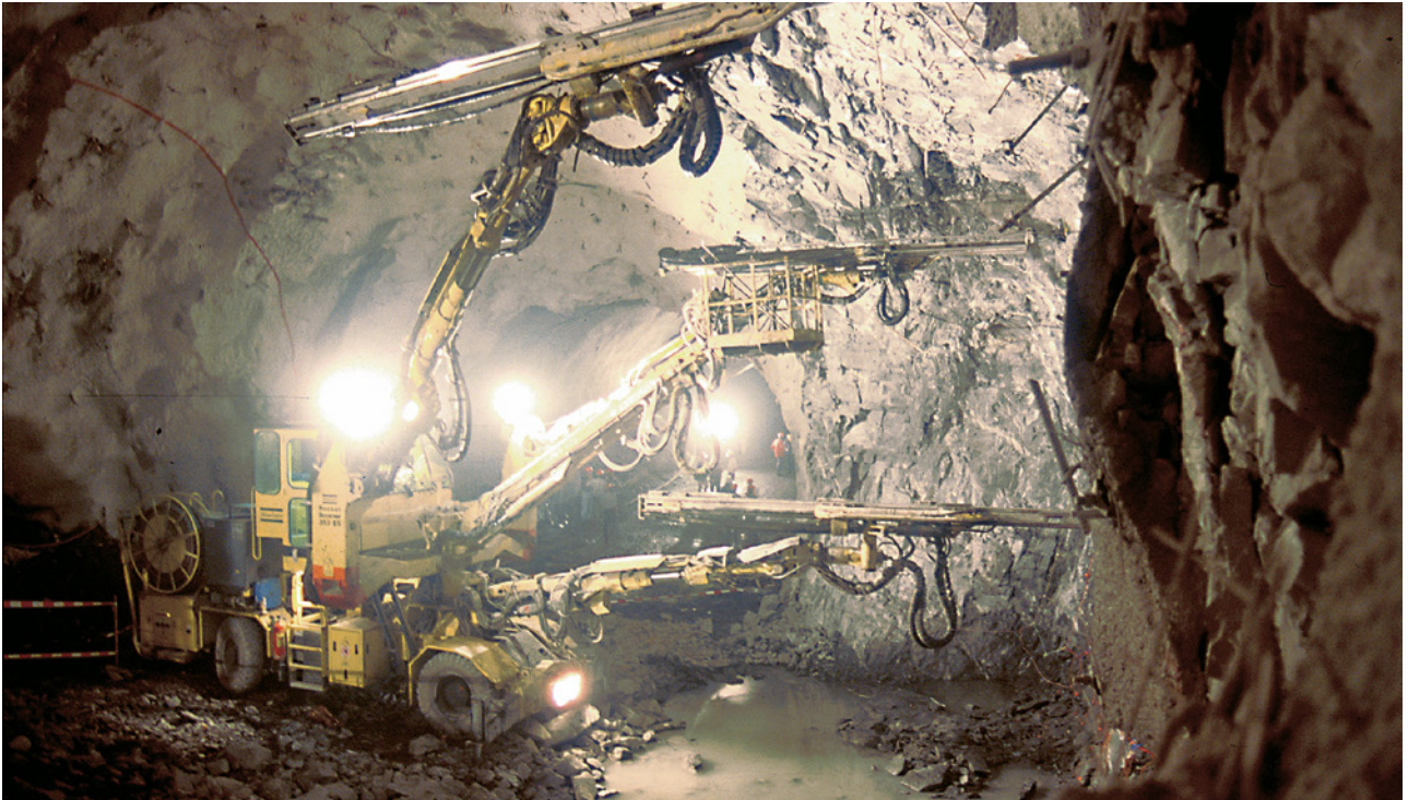
1 Postes de travail exposant fortement au bruit sur un chantier de creusement d'un tunnel
