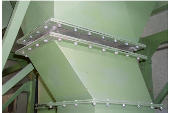
69 Joints en matière synthétique pour la conduite d'évacuation de l'air d'une unité de fabrication
