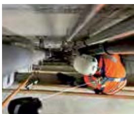
Protection par encordement
