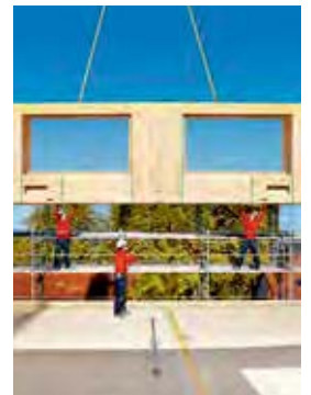
Construction en bois
