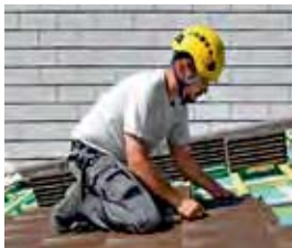
Toitures et façades
