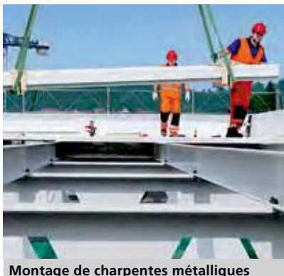
Montage de charpentes métalliques
