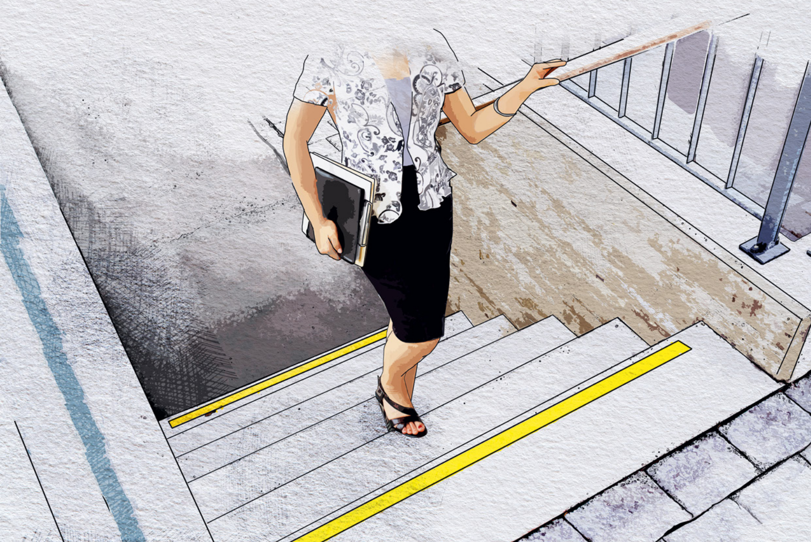
Corrimani e segnaletica in corrispondenza degli ultimi gradini di una scala riducono il pericolo di inciampare.
