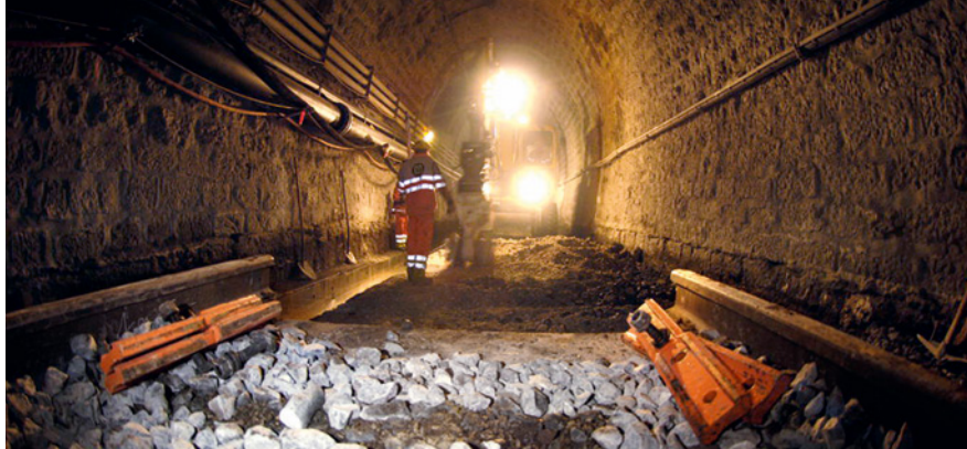
Alte concentrazioni di ossidi di azoto nell'aria si possono produrre ad esempio durante il risanamento di vecchie gallerie ferroviarie dagli spazi ristretti. (fonte: Emch und Berger)
