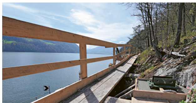
30 In caso di lavori importanti, ad es. ancoraggio e messa in sicurezza di pareti rocciose, gli accessi ai posti di lavoro devono essere messi in sicurezza. La protezione laterale deve essere adattata alle condizioni del luogo (secondo l'Ordinanza sui lavori di costruzione, artt. 15 e 16).
