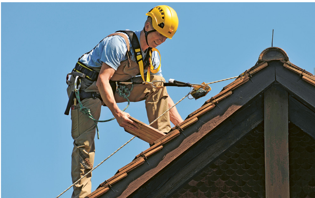
9 Lavori di riparazione eseguiti da un operaio munito di imbracatura anticaduta e fune di sicurezza. La lunghezza della fune può essere regolata mediante un cordino regolabile o un dispositivo anticaduta di tipo guidato regolabile montato sulla fune di sicurezza.
