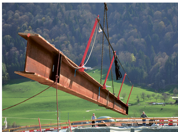
26 Pianificazione accurata: una trave in acciaio viene sollevata con un sistema di linee vita pre-teso.
