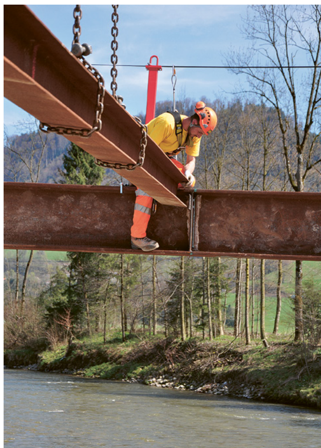
25 Montaggio di una struttura in acciaio con dispositivo di sicurezza su linea vita orizzontale.
