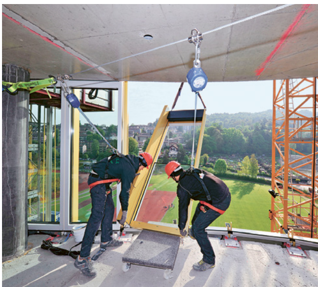
24 Operai al lavoro su un lato aperto verso il vuoto. Gli operai sono agganciati a una fune metallica mediante un'imbracatura anticaduta e un carrellino scorrevole. Diversi sistemi di fissaggio e scorrimento del carrellino permettono di superare senza interruzioni i rompitratta intermedi eventualmente montati sulla fune metallica.
