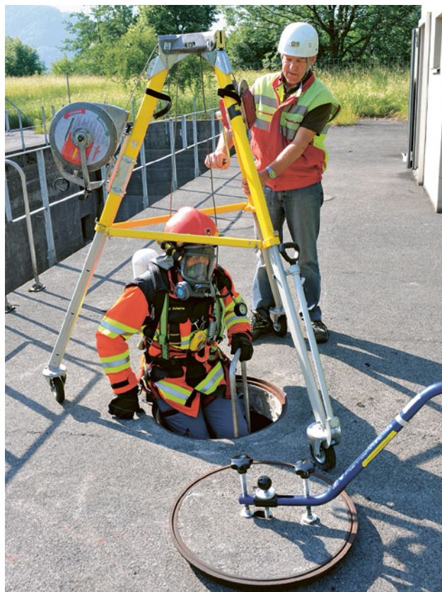
21 Discesa in un pozzo tramite una scaletta. L'operaio è assicurato con un'imbracatura e un dispositivo anticaduta provvisto di manovella di salvataggio che permette di sollevarlo dall'esterno in qualsiasi momento.
