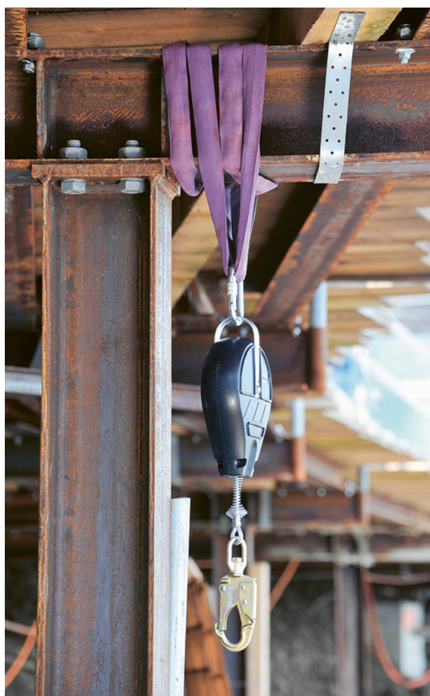
23 Fissaggio della fune di sicurezza all'elemento portante di una struttura
