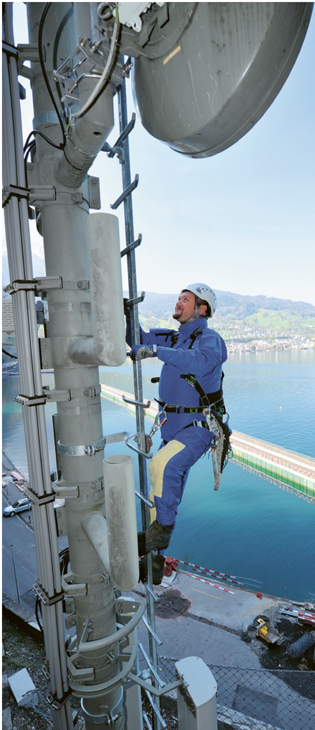
14 Montatore assicurato con un dispositivo di risalita sul binario di guida di una scala fissa a pioli
