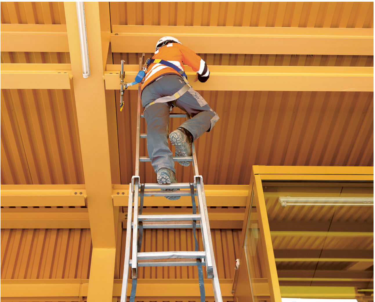
27 Lavori in sicurezza su una scala dotata di dispositivo anticaduta di tipo retrattile e punto di ancoraggio mobile
