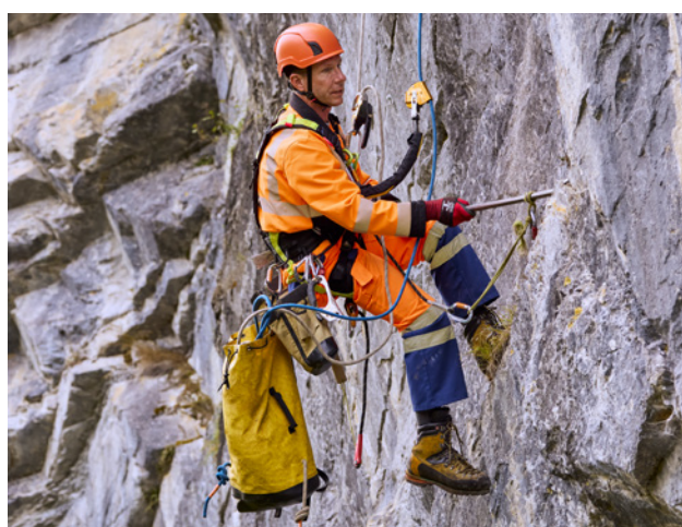
7 Lavori in sospensione a corde portanti (APF) con sistema di lavoro e di sicurezza
