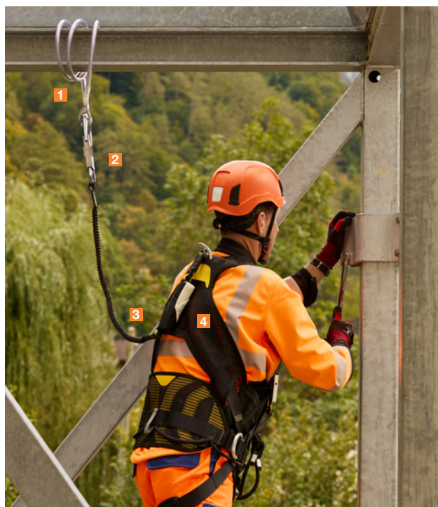
1 Dispositivo anticaduta con sistema di arresto caduta: 1 dispositivo di ancoraggio mobile, 2 connettore, 3 cordino con assorbitore di energia, 4 imbracatura anticaduta
