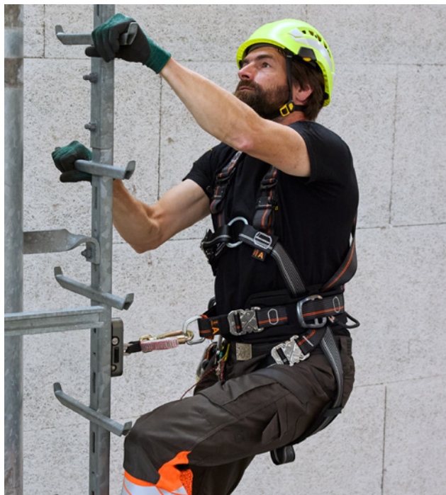
25 Dispositivo anticaduta di tipo guidato comprendente una linea di ancoraggio rigida con binario (SN EN 353-1)
