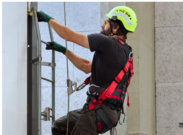
26 Dispositivo anticaduta di tipo guidato comprendente una linea di ancoraggio flessibile costituita da una fune metallica (SN EN 353-2)
