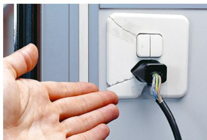
2 Enveloppe isolante endommagée et câble défectueux: risque d'électrisation.
