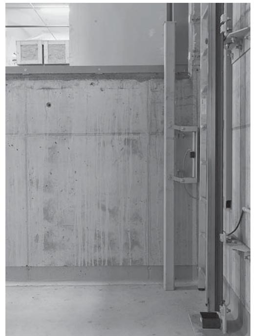
Bild 3: Manuell betätigte mechanische Einrichtung (Wartungsstütze), hier bei einem Aufzug mit Schachtgrube
