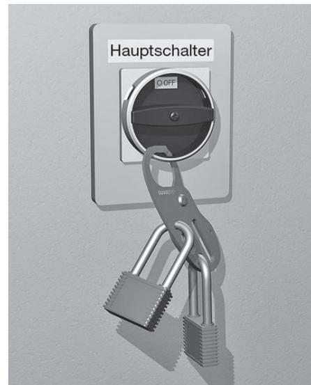
Bild 6: Abschlüssbarer Hauptschalter
