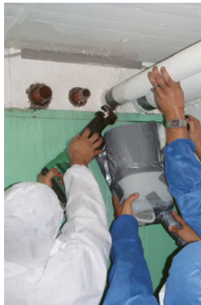
4 Schneiden eines Rohres mit der Fuchsschwanzsäge
