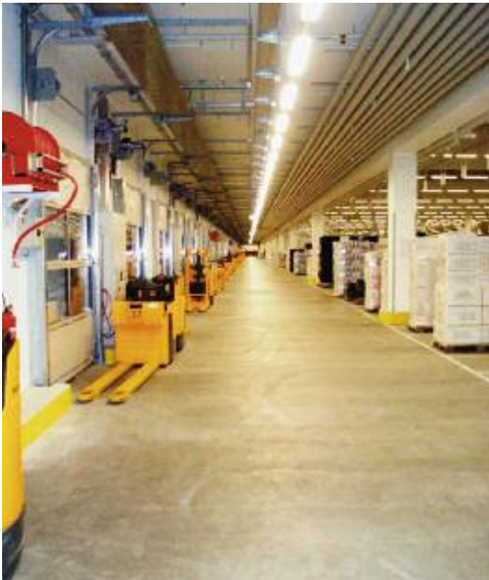
Abbildung 2: Hauptfluchtweg in einer Nahrungsverteilzentrale
