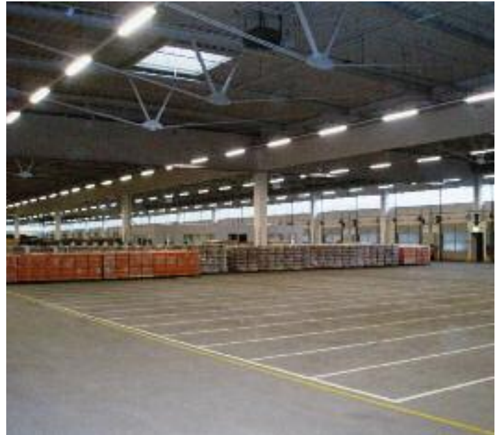
Abbildung 3: Problematik der Anzahl und Sichtbarkeit der Notausgänge in der gleichen Nahrungsverteilzentrale.
