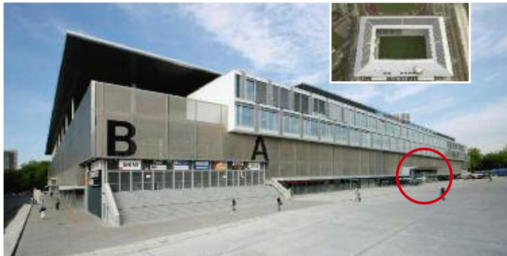
Abbildung 1: Stade de Suisse mit Einkaufszentrum in Bern. Letztere besetzt einen Teil des Untergeschosses. Rot eingekreist: Eingang Einkaufszentrum.
