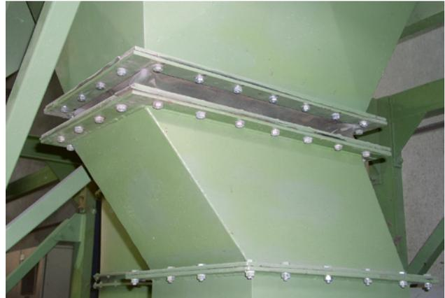
69 Kunststoff-Kompensator bei der Abluftleitung einer Prozessanlage
