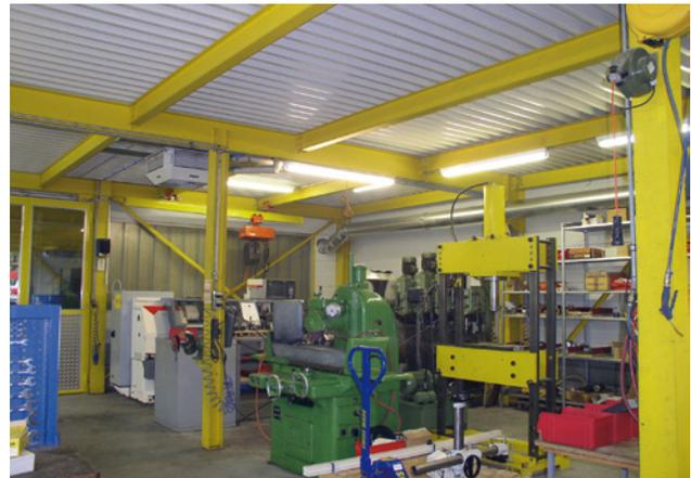
**79** Typischer Fabrikationsraum: Stahlbau mit Profilblech, ohne wirksame Akustikdecke. Dieser Raum wirkt sehr hallig, und der Maschinenlärm stört stark im ganzen Raum.
