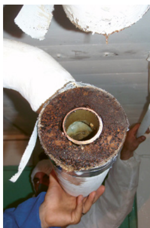
7 Tubo sezionato avvolto nella pellicola di plastica
