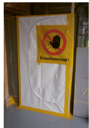
3 Zona di lavoro confinata e segnalata
