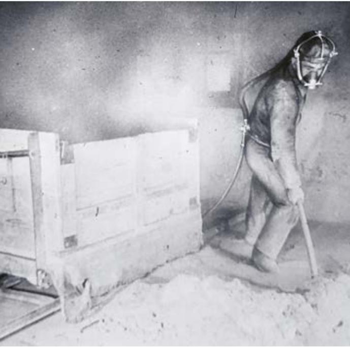
2 Sandstrahler mit Suva-Frischlufthgerät beim Sandschaufeln
