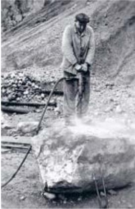
**3** Die meisten Silikosen werden heute in der steinverarbeitenden Industrie anerkannt. Sie sind häufig Altlasten früherer grosser Quarzstaubbelastungen wie hier bei einer Trockenbohrung in einem Steinbruch, wie sie heute nicht mehr stattfinden.
