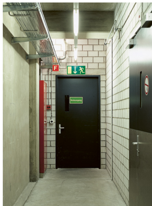
3 Fluchtweg mit Türe, die sich in Richtung des Fluchtweges öffnen lässt
