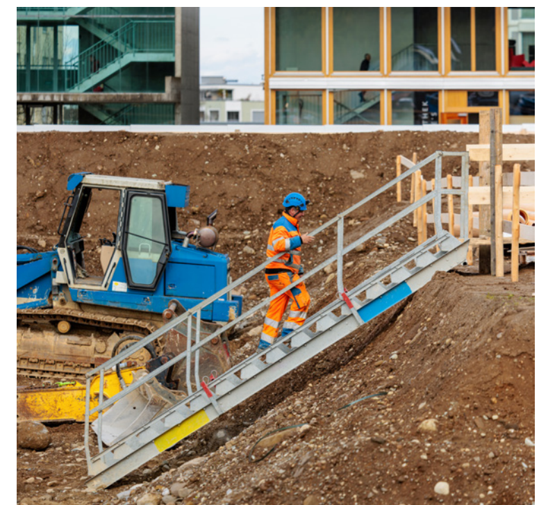
Regel 8: Wir erstellen sichere Zugänge zu sämtlichen Arbeitsplätzen.
