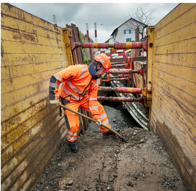
Regel 9: Wir sichern Gräben und Baugruben.
