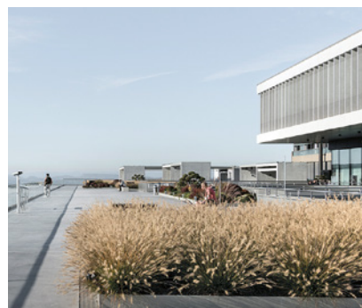
Au terme des travaux, la clinique apparaît dans un nouvel éclat.
