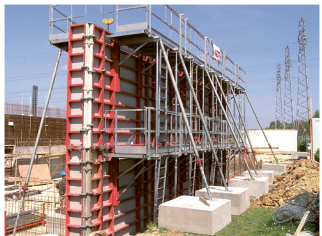
2 Verankerung des äusseren Wandschalungselements mit Richtstützen auf Betonelementen.
