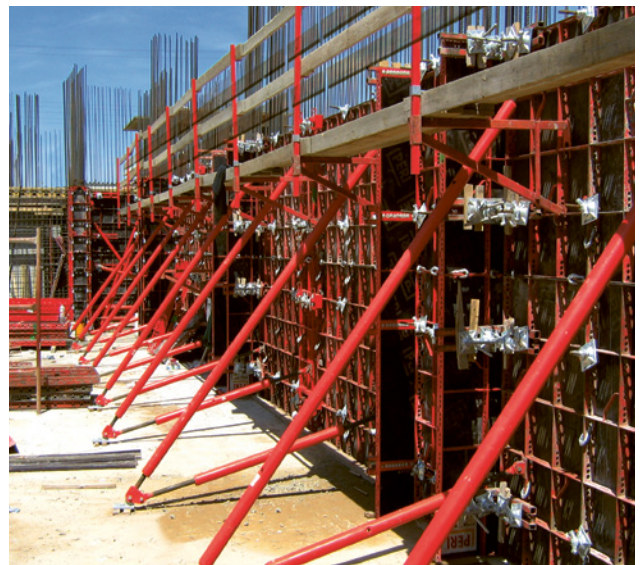
1 Wandschalungselemente, zug- und druckfest im Untergrund verankert und an der Kopf- und Fussseite befestigt.
