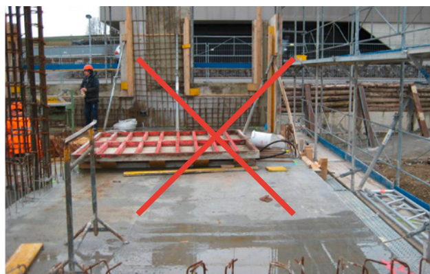
4 Als ein Monteur im oberen Bereich der Wandschalung etwas montierte, kippte das Element um und begrub den Mann unter sich. Abstützungen mit Deckenspriessen dürfen auf keinen Fall toleriert werden.
