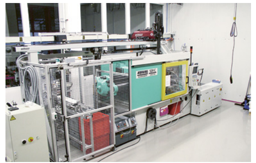
5 Ampia barriera attorno a un'isola di produzione con porta di accesso controllata da un dispositivo elettrico
