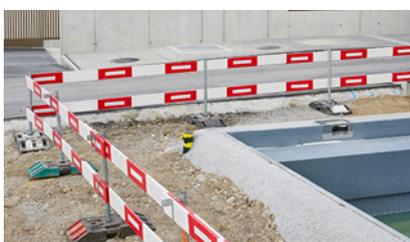
1 Barrière de protection avec socle en caoutchouc
