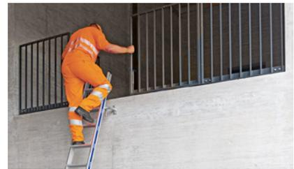
3 Dispositif de retenue, garde-corps périphérique et sommet de l'échelle sécurisé
