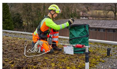
3 Protection contre les chutes avec système d'arrêt des chutes
