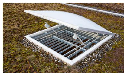
3 Puits de lumière sécurisé durablement avec un grillage intérieur
