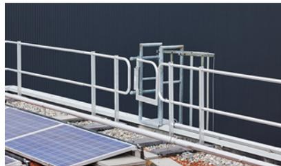
2 Garde-corps périphérique au point de sortie d'une échelle
