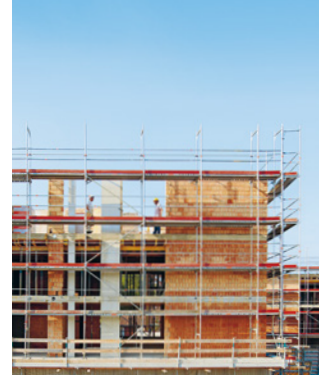
Regel 4 Mit Fassadengerüst arbeiten
