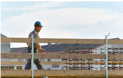
1 Absturzkante an Deckenschalung (z. B. bei Betonierunterbrüchen)
