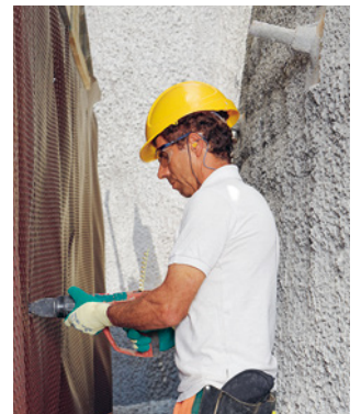
Regel 8 Gräben und Baugruben sichern
