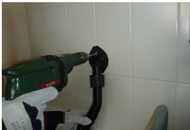
4 Perceuse avec aspiration à la source pour les carreaux en céramique comportant de la colle amiantée.
