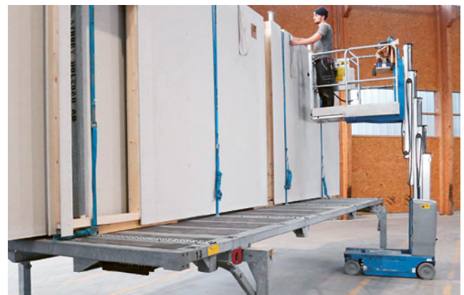
1 Fixation des éléments en bois au moyen de dispositifs d'arrimage.
