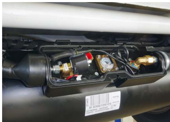
Bei erhöhtem Druck durch äussere Erwärmung kann es bei LPG-Tanks zu einem Abblasen des Gases kommen.
