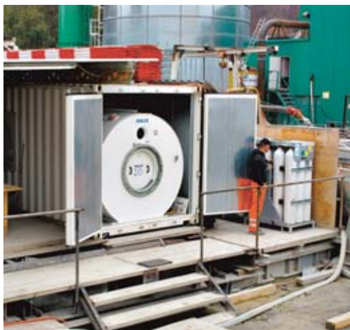
Figure 23a Exemple de caisson thérapeutique installé dans un conteneur sur un chantier.
