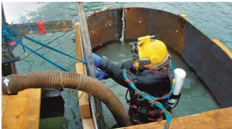
Figure 6c Batardeau en acier pour la coulée du béton d'une fondation de pile de pont. Descente d'un plongeur pour fixer les fers d'armature à poser sous l'eau. Le plongeur est alimenté en air depuis la surface par un tuyau. Il porte une réserve de gaz de secours sur le dos.
