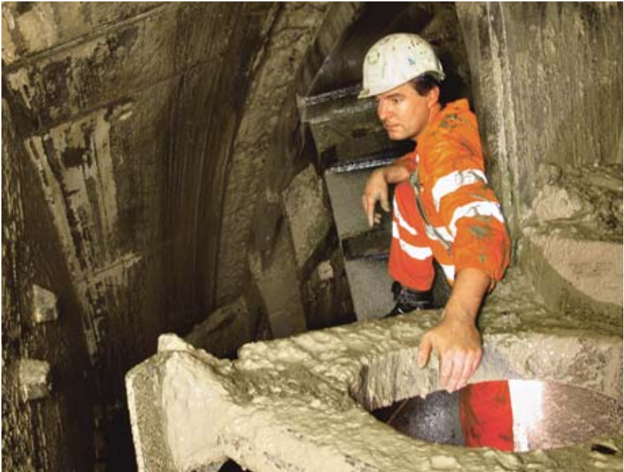
Figure 9c Une fois le niveau de la bentonite abaissé, on peut inspecter la roue d'abattage, sous une pression d'air pouvant atteindre 2,5 bars.
