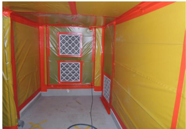
1 Sanierung: Zone mit UHG (Unterdruckhaltungsgerät) und Schleuse
