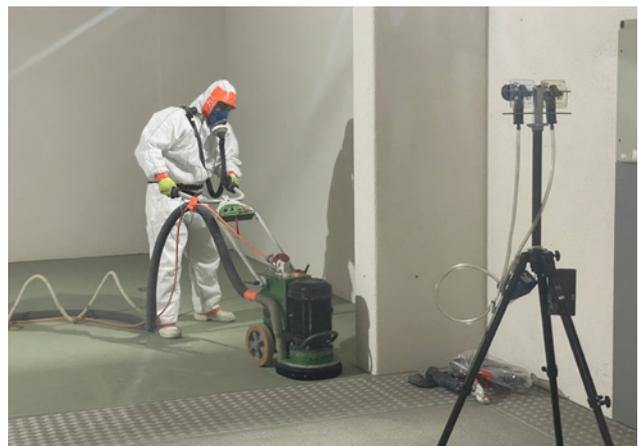
2 Sanierung: Mobile Bodenschleifmaschine mit Quellenabsaugung
