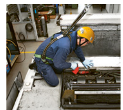
5 EPI contre les chutes de hauteur
