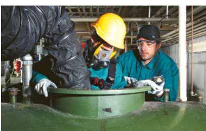
1 Meulage dans une citerne propre: ventilation et protection respiratoire nécessaires
