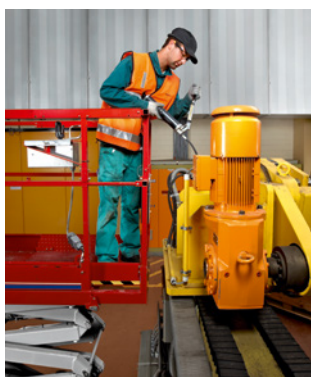
Règle 5 Prévenir les chutes.
