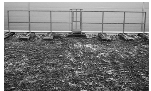
6 Parapetto posto lungo la zona di caduta su entrambi i lati del piano di arrivo
