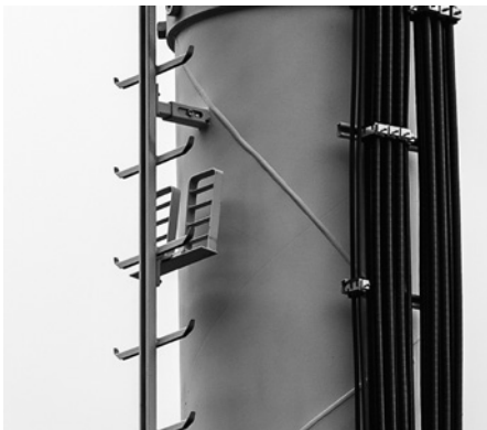
11 Pedata ribaltabile sulla scala con corrente intermedio
