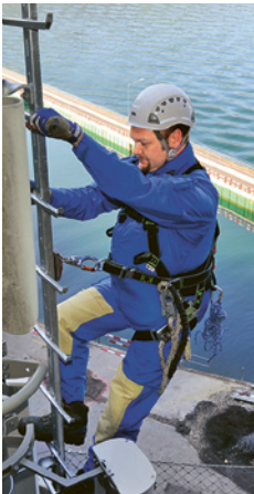
1 Scala fissa a pioli con corrente intermedio e sistema anticaduta. L'uso in sicurezza delle scale fisse a pioli non consente il trasporto di materiale con le mani.
