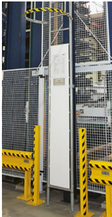
2 Scala fissa a pioli con protezione dorsale. La scala è dotata di sbarramento di sicurezza per impedire l'accesso a persone non autorizzate.
