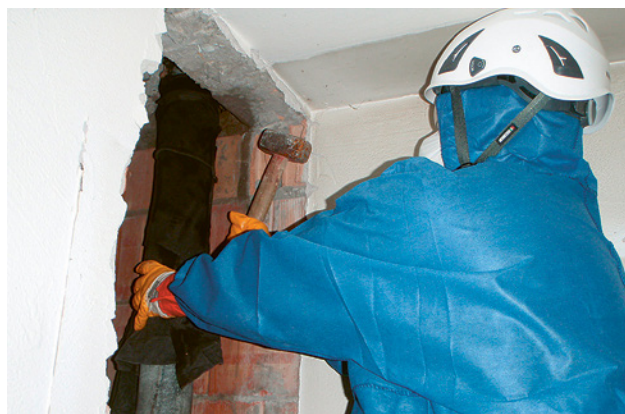
1 Ein Asbestzementrohr wird mit einem kontrollierten Hammerschlag gebrochen.
