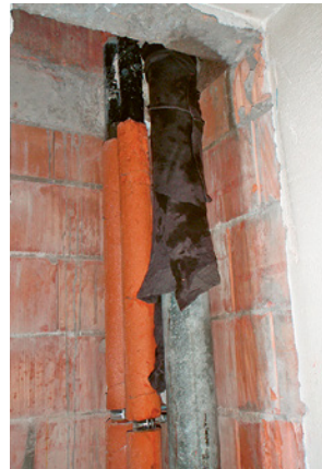
2 Die geplante Bruchstelle wird mit einem Stofftuch umwickelt.
