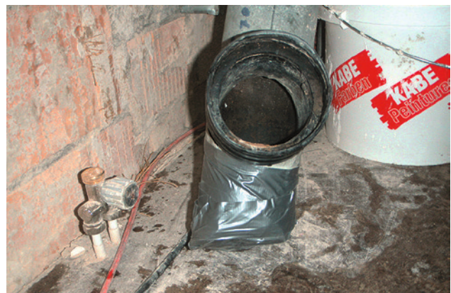
4 Abgeklebte Bruchkante, vorbereitet für die Entsorgung.
