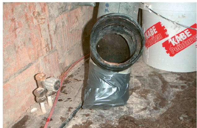
4 Abgeklebte Bruchkante, vorbereitet für die Entsorgung.
