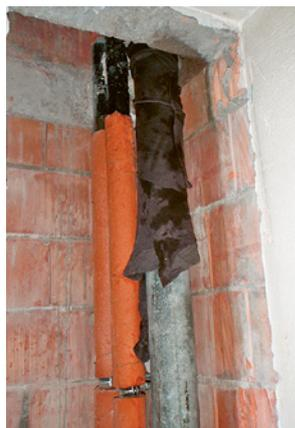
2 Un panno di stoffa viene avvolto nel punto in cui si rompe il tubo.
