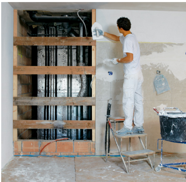
16 Plâtrier en train d'enduire une cloison
