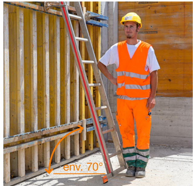
35 Vérification de l'angle grâce au test du coude
