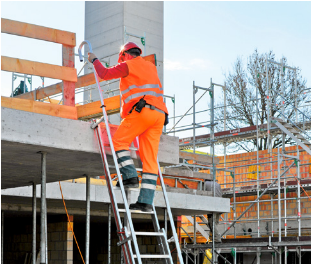
34 Montants rallongés pour garantir la sécurité de l'utilisateur
