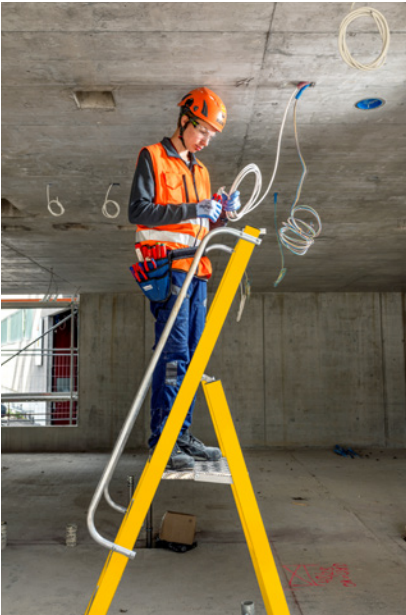
19 Travaux de câblage dans un bâtiment
