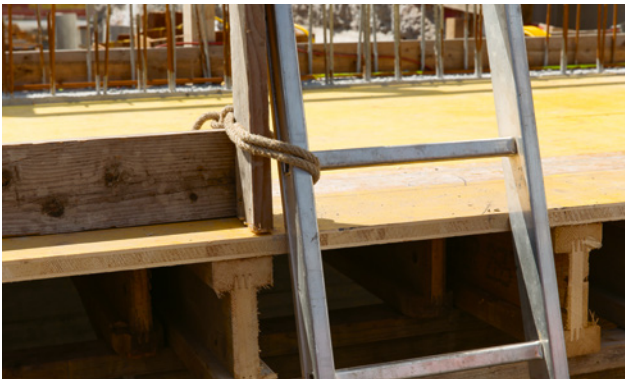
43 Fixation avec une corde
