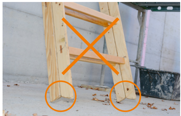
26 Lorsque l'échelle double est utilisée comme échelle simple, elle repose uniquement sur le bord des pieds.
