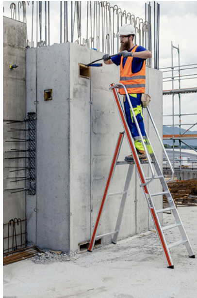
20 Travaux sur un mur en béton
