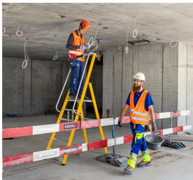
3 Sécurisation de l'échelle dans le passage
