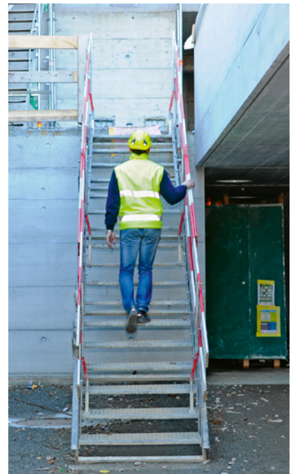
9 Escalier de chantier
