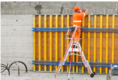
5 Échelle mobile avec plateforme (EN 131-7)
