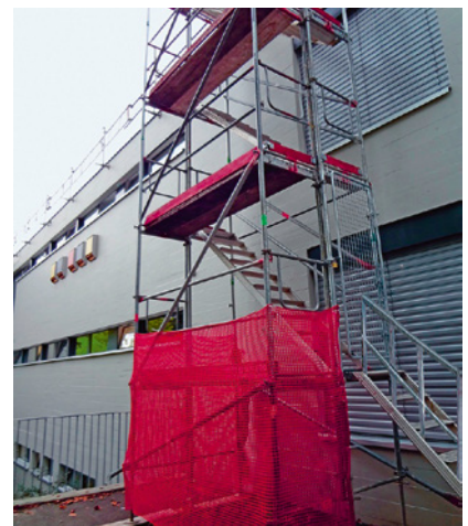
12 Tour d'escalier pour échafaudage
