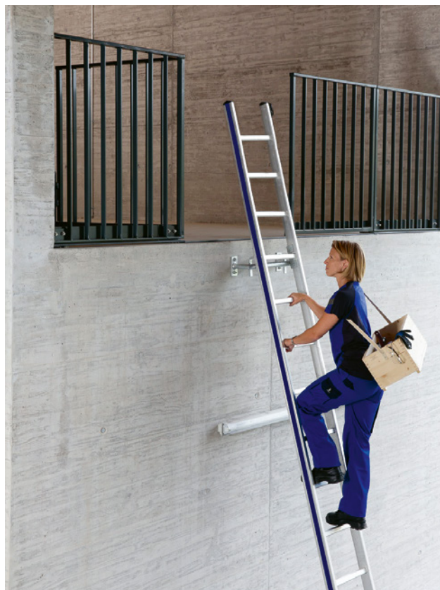
47 et 48 Le regard et le corps vers l'échelle, les mains sur les échelons et un accessoire approprié (trousse ou caisse à outils).
