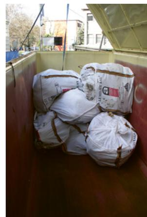
7 Benne pouvant être fermée à clef.
