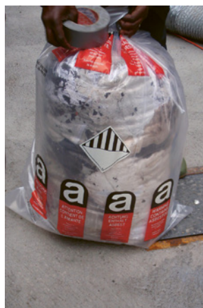
6 Sac en plastique avec marquage «Amiante».
