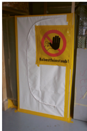
4 La zone d'assainissement est clairement signalée et délimitée.
