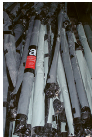
5 Tuyaux emballés prêts pour le transport vers l'entreprise de désamiantage.
